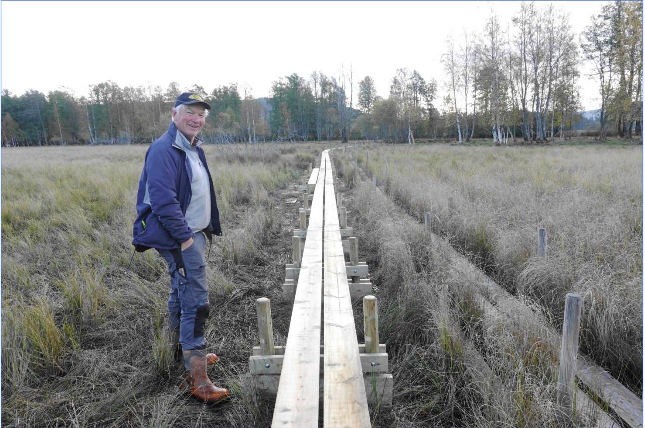
Ny klopp over Hegstadmyra med fornøyd byggansvarlig Edvard Lundteigen 30.09.24. Foto: Steinar Stueflotten
