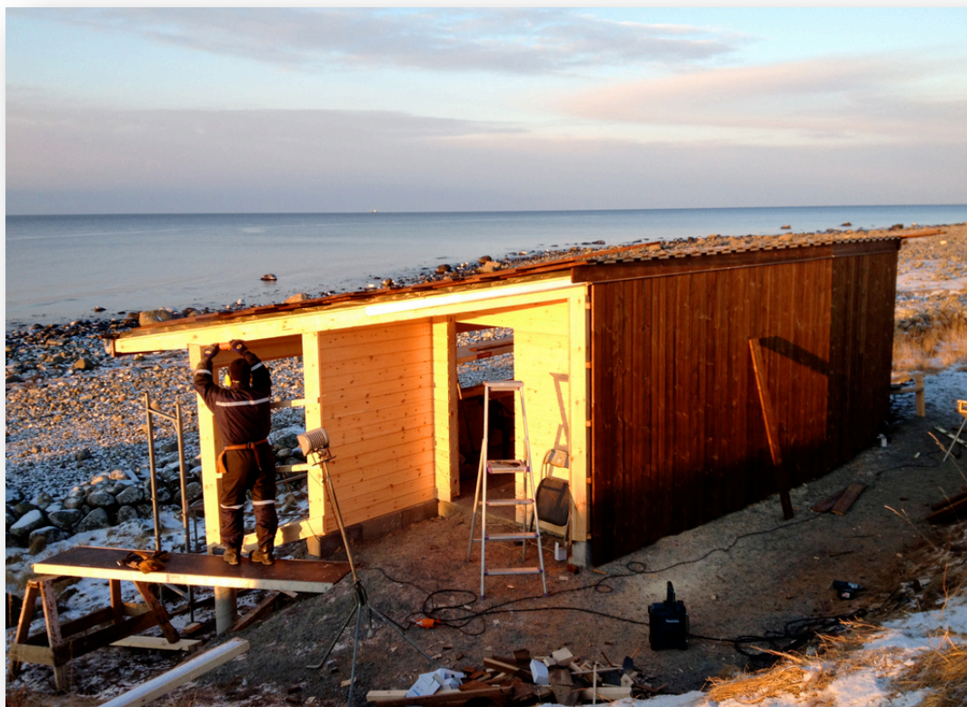
Sjøfuglbua utenfor Lista Fyr under bygging vinteren 2012. Foto: M. Wold.
