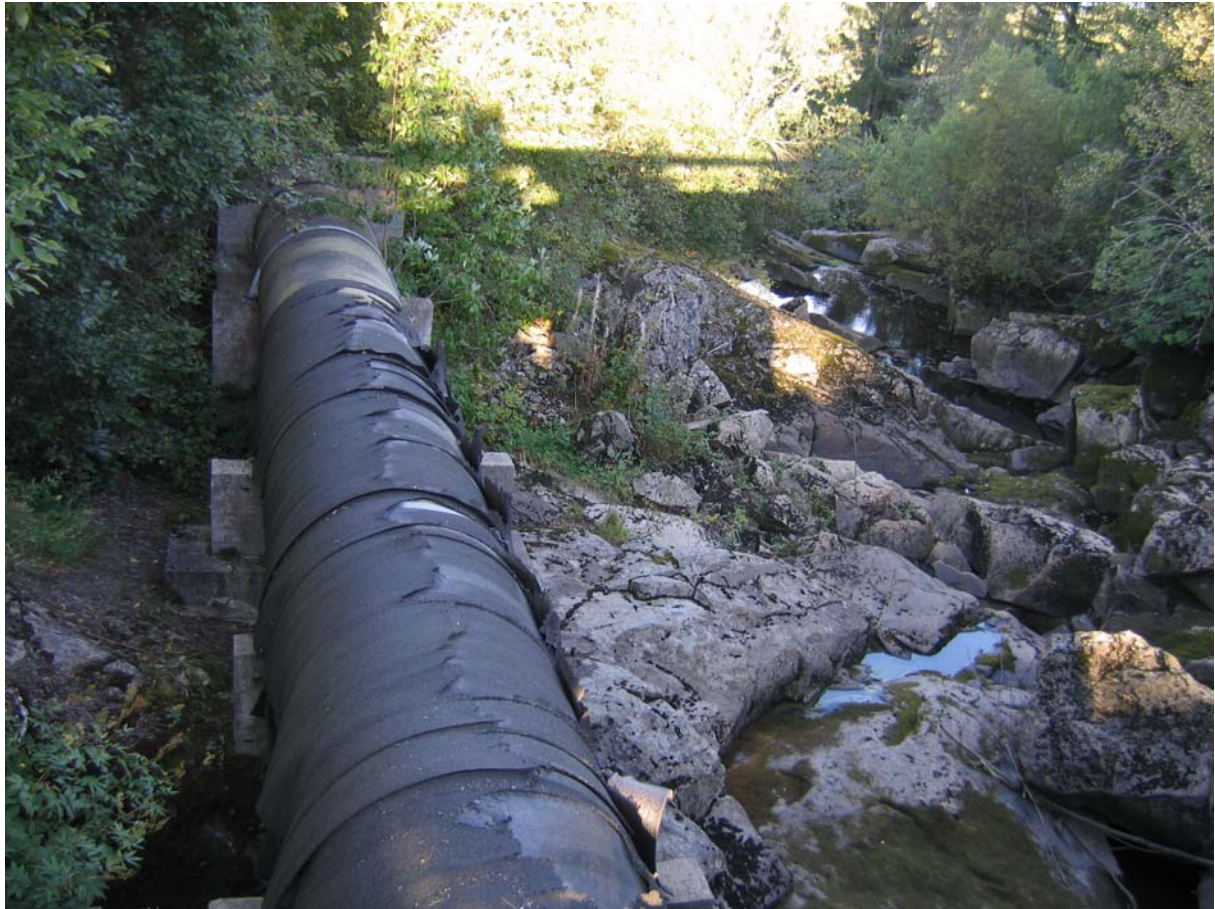
Periodevis eller permanent tørrlagte elveleier fører til nedgang i byttedyr og vanligvis tap av reirplasser. Foto: Trond Øigarden.
